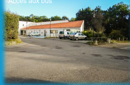
Accès aux bus
